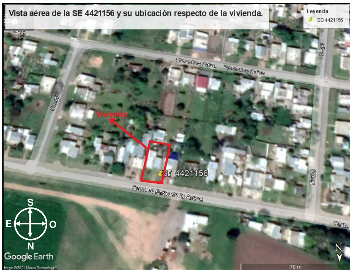
Figura 6– Vista aérea de la subestación SE 4421156 y su ubicación respecto de la vivienda.
